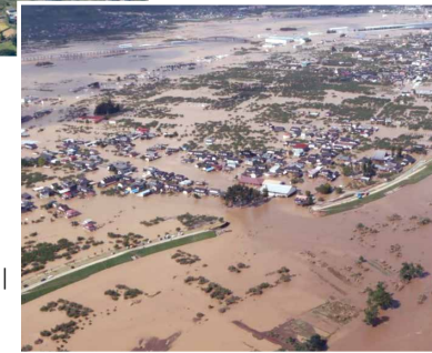
▶阿武隈川水系阿武隈川の氾濫(福島県郡山市) 提供:国土交通省
