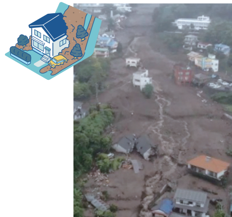
熱海市の土石流／提供:国土交通省
