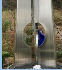
塔表面を手作業で磨きました
